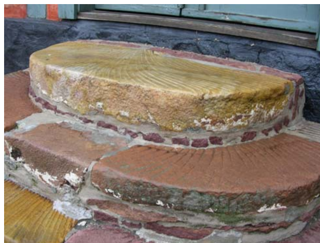
Trappe af gamle møllesten i Toldbodgade – Hintzes gård- i Rønne. Øverst en balkasandsten, derunder en nexø sandsten, og længere nede igen flere balkasandsten.
