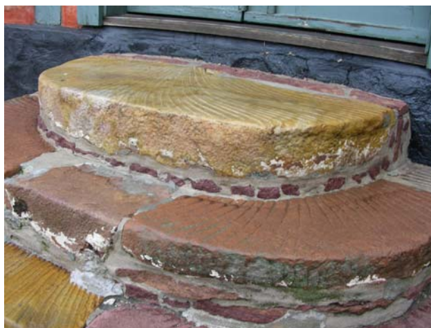
Trappe af gamle møllesten i Toldbodgade – Hintzes gård- i Rønne. Øverst en balkasandsten, derunder en nexøsandsten, og længere nede igen flere balkasandsten.
